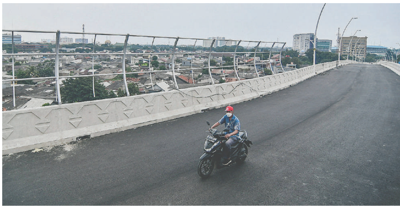
MENJELANG UJI COBA: Seorang pengawas melintas di jalan layang Cakung, Jakarta Timur, kemarin. Progres pembangunan jalan layang Cakung sejauh 760 meter dan lebar 18 meter tersebut telah mencapai 96% dan rencananya uji coba akan dilakukan pekan ini.
