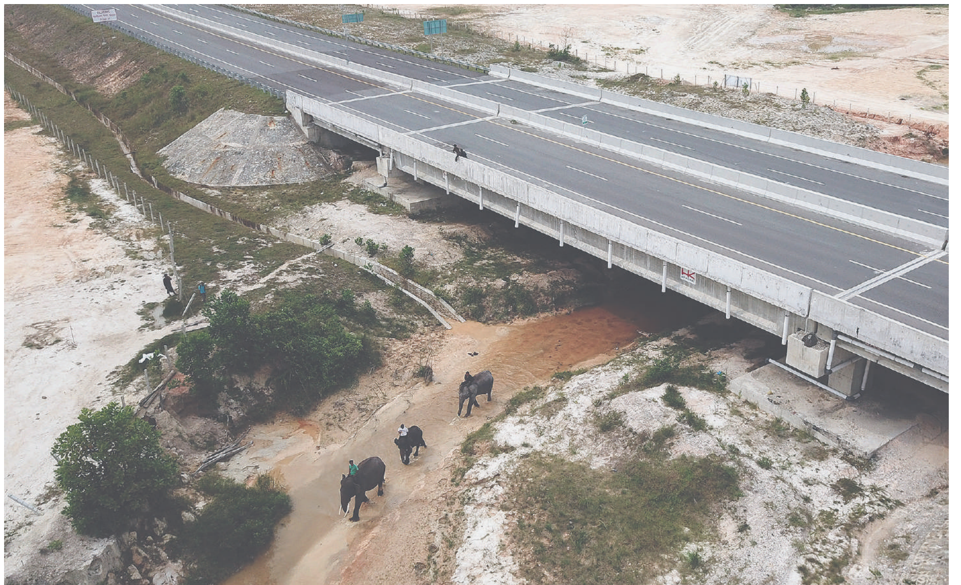
TEROWONGAN GAJAH TOL PEKANBARU DUMAI: Gajah sumatra binaan Pusat Latihan Gajah Minas Riau melewati jalur terowongan gajah di bawah Jalan Tol Pekanbaru-Dumai, Riau, kemarin. Jalan Tol Pekanbaru-Dumai yang merupakan bagian dari Tol Trans-Sumatra, memiliki lima terowongan gajah yang didesain aman untuk perlintasan gajah di wilayah jelajahnya yang dilintasi jalan tol sepanjang 131 kilometer itu.
